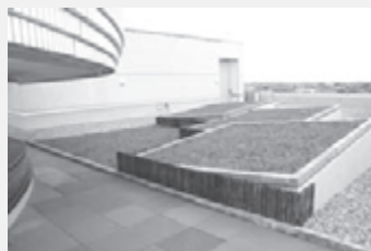
② 屋上緑化 (森戸センター)
