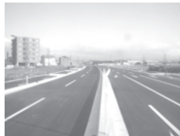
焼却灰入りアスファルト舗装
