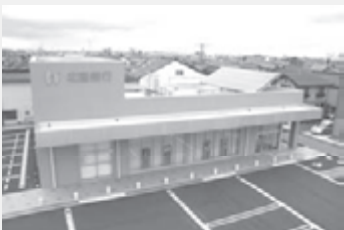
③太陽光パネル (円光寺支店)
