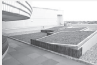
②屋上緑化 (森戸センター)
